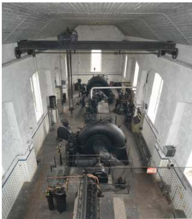
4. Унутрашњи постор машинске куће, јун 2013. 4. Interior of Engine House, June 2013
