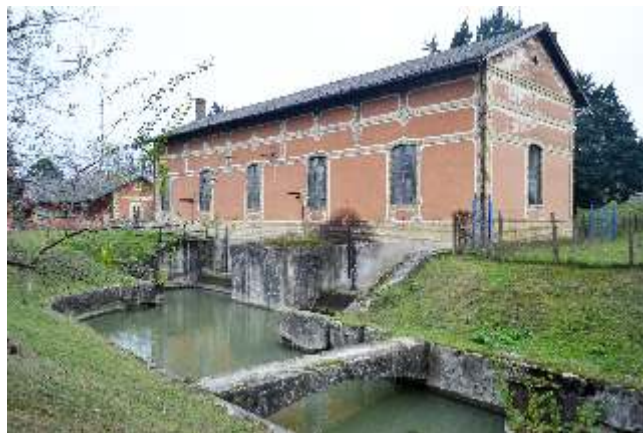
1. Црпна станица „Плавна“ – машинска кућа, јун 2013. 1. Pumping Station "Plavna" – Engine House, June 2013
