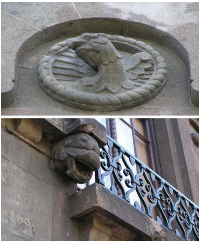
8. Камена декорација главне фасаде 8. Stone decoration of the main elevation
